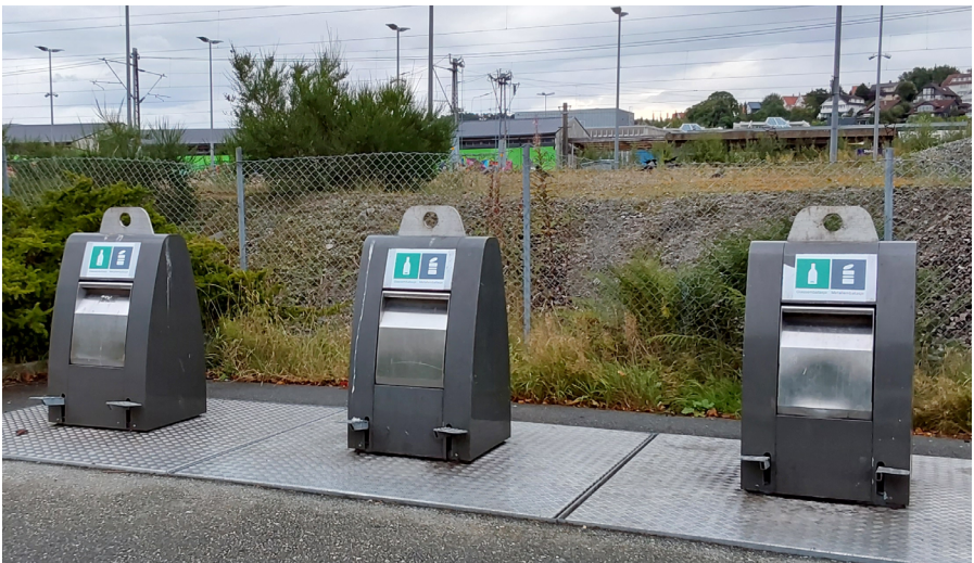
Nedgravde avfallsbrønner utenfor Mega Brueland i Sandnes. Foto: AKS
